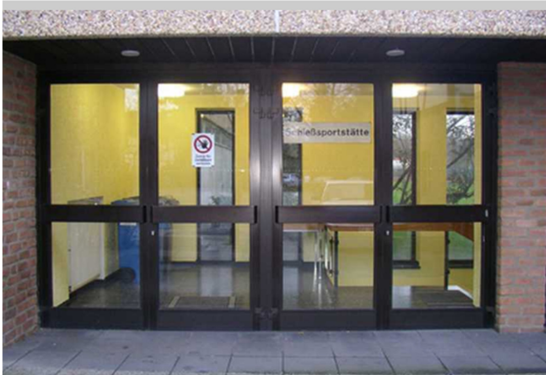
Eingangsbereich Schießstand (Türklingel links, der Schießstand befindet sich im Keller)
